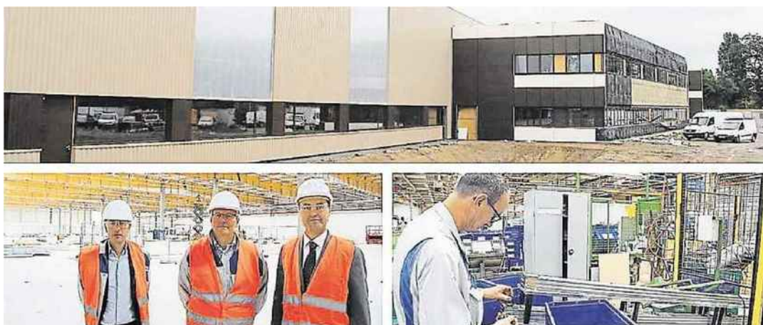
A Rennes, dans le nouveau bâtiment où seront produites les pièces antivibratoires à partir de septembre : Gilles Guérin directeur des opérations qui suit les chantiers de Rennes et Vitré, entouré de Ludovic Le Gall (à gauche) directeur des ressources humaines et Sylvain Broux, directeur de Cooper Standard France
