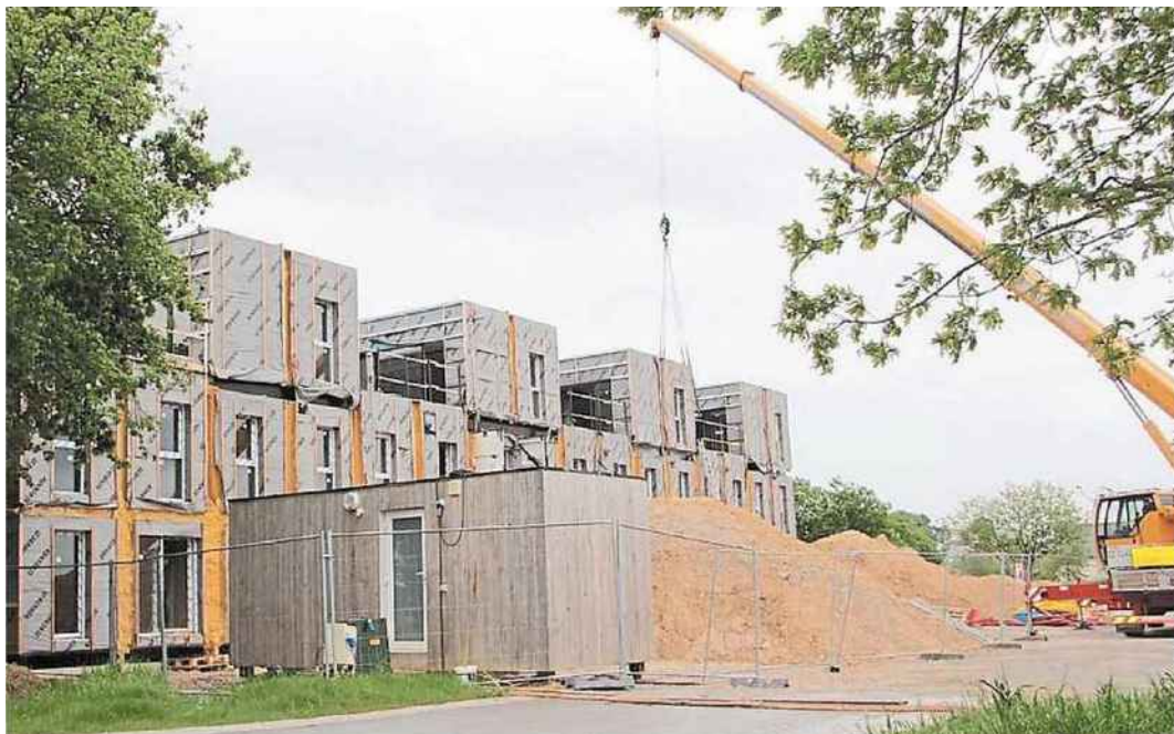
Le chantier de construction d'un collectif de 14 logements est en cours. Les locataires devraient s'installer cet automne.
