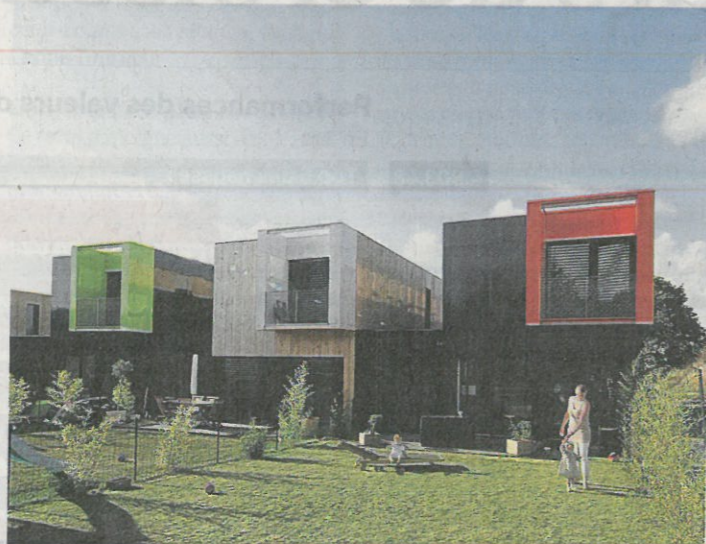
Lamotte a passé un accord avec la société rennais B3 Ecodesign, qui commence à aménager des conteneurs maritimes. Photo B3 Ecodesign
